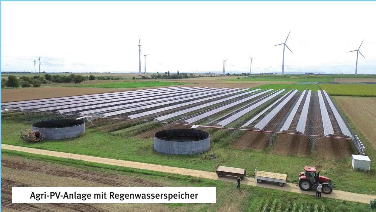
Agri-PV-Anlage mit Regenwasserspeicher
