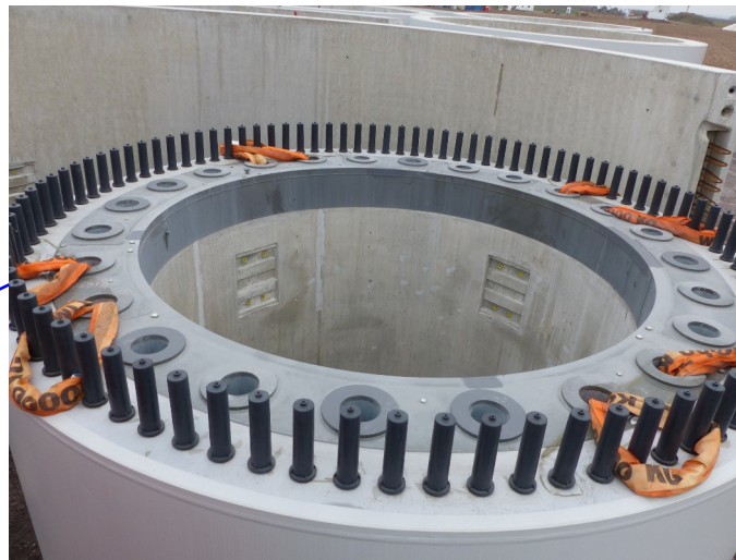
Adapterstück: Spannbeton - Stahl
